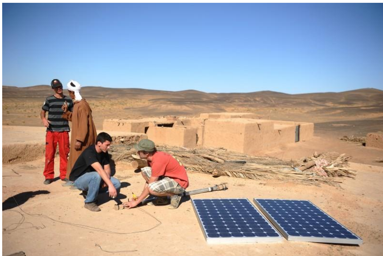
7- Equipages installant des panneaux solaires
